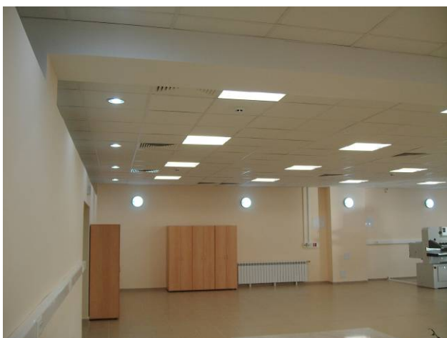
Фиг. 2. Осветителна уредба на основно помещение на Печатна база
